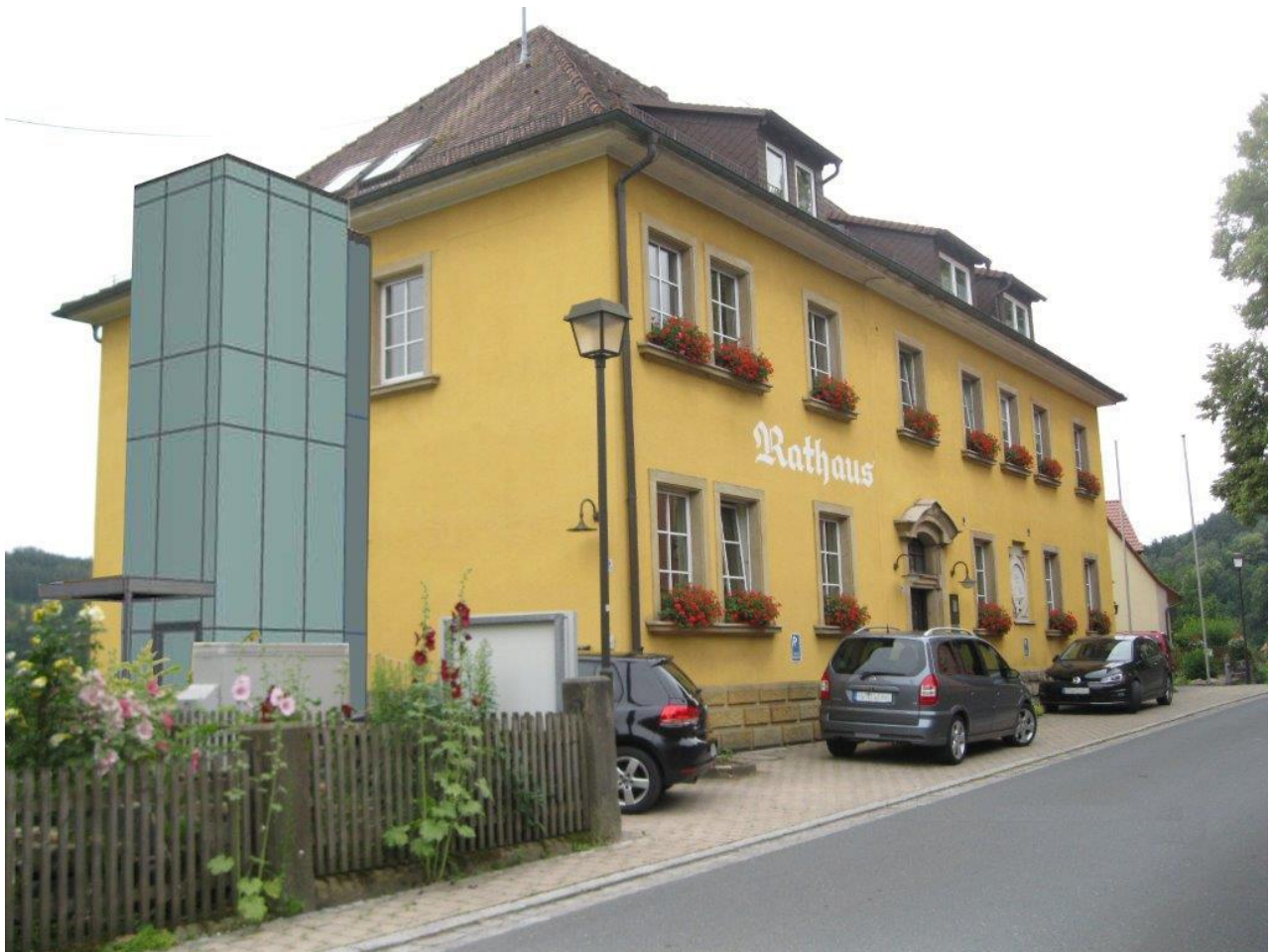
Ansicht Verwaltungsgebäude VG Trebgast mit Aufzug
